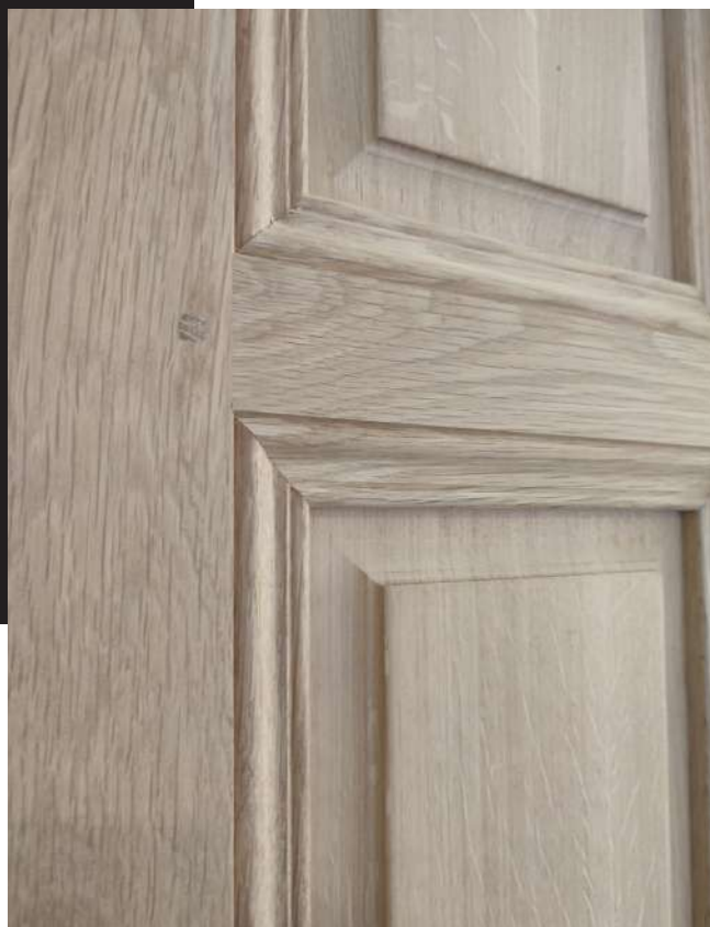
↓ Porte d'entrée cintrée en chêne Massif, moulures sur mesure raccordées à coupe d'onglet Panneaux isolés en liège - Chevillage à l'ancienne
