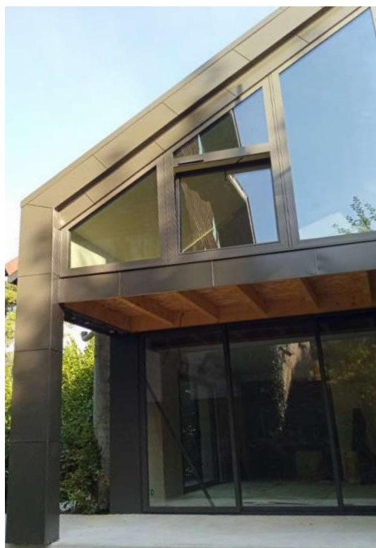
↓ Pignon entièrement vitrée – châssis en aluminium
